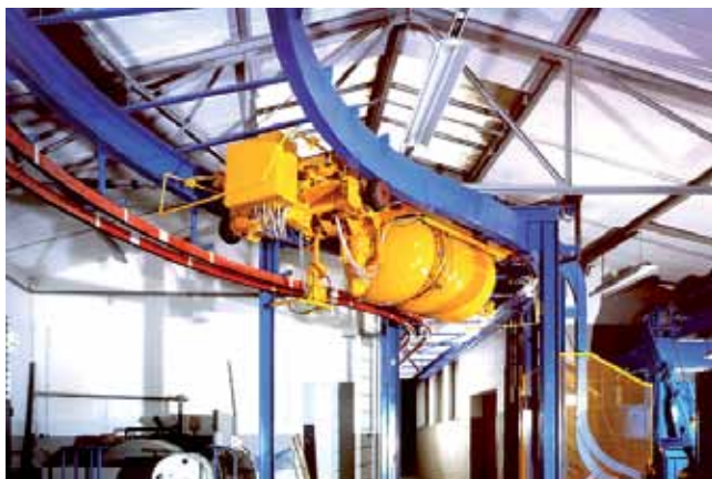
Питание и управление на бетонном заводе
