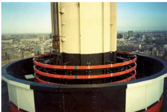
4 замкнутых изогнутых токопровода для вращающегося лифта
